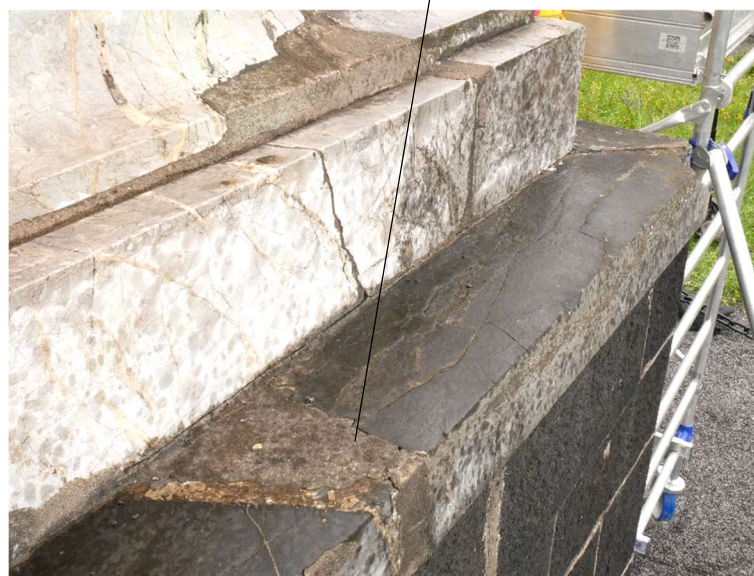
Blocs très altérés et fissurés ; rebouchage des joints et des fissures en mortier de ciment
