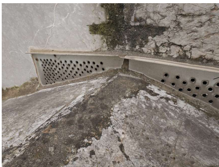
Ouverture sur des puits d'aération à l'intérieur de la base
