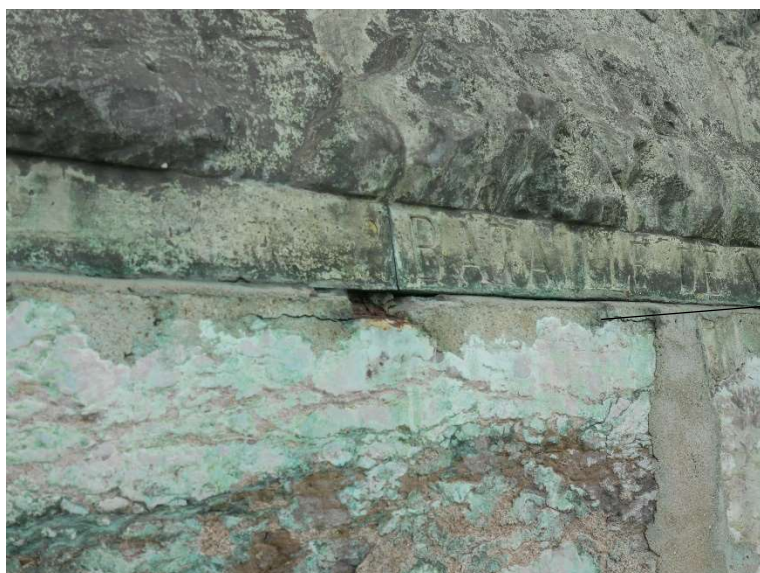
Oxydation des attaches des plaques de bronze ; coulures d'oxyde de cuivre sur le marbre
