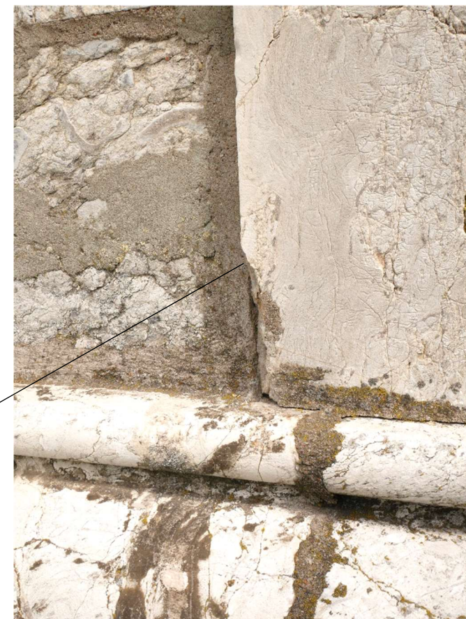
Epaufures, ouverture de joints, rebouchage au mortier de ciment
