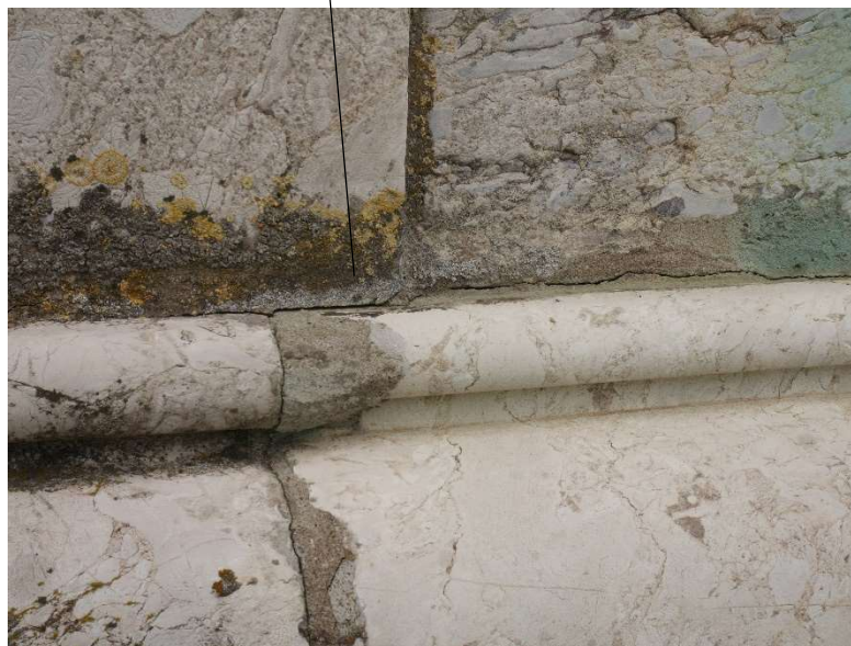
Joints ouverts ; blocs de marbre altérés et mortier de ciment
