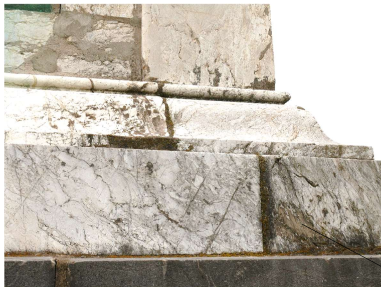
Bloc de marbre altéré et joint en mortier de ciment
