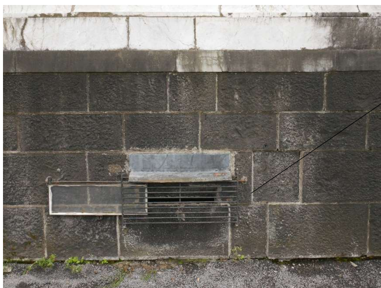
Oxydation du système de fermeture et de l'étanchéité du soupirail ; mouvements de maçonnerie
