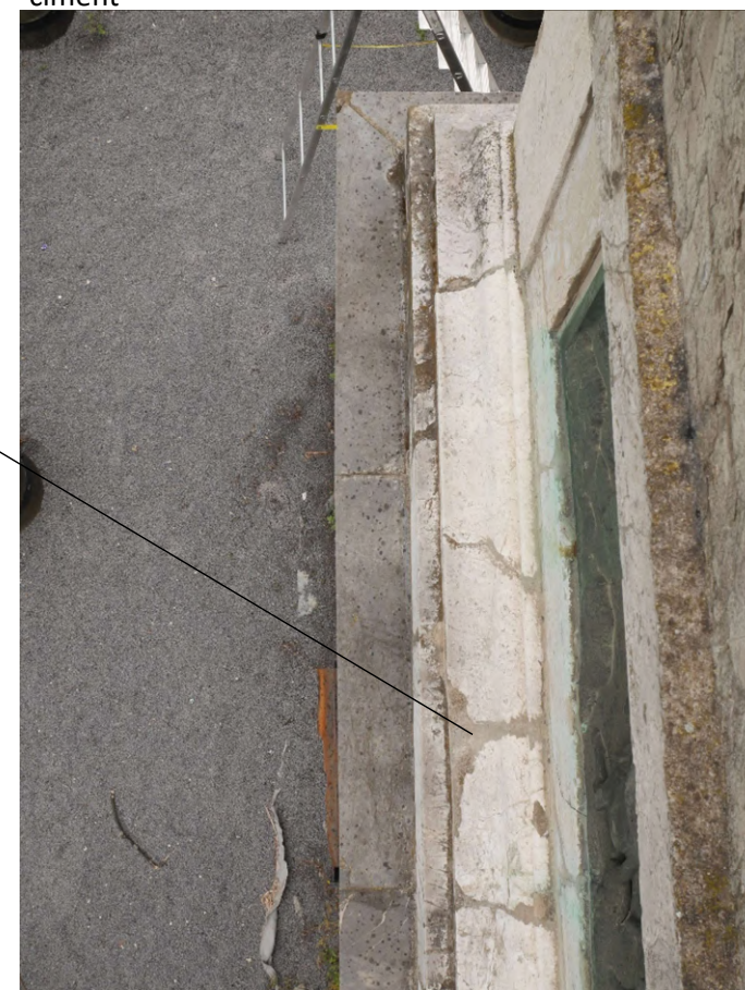
Rebouchage de fissures au mortier de ciment
