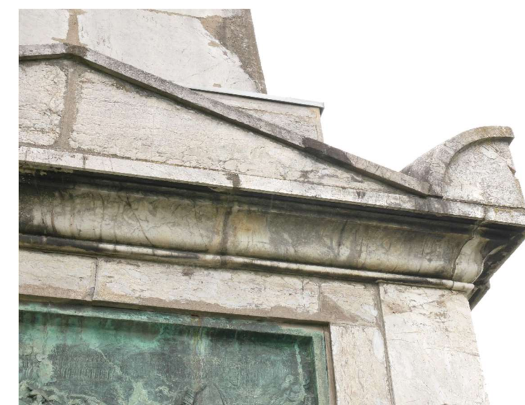
Blocs de marbres altérés et brisés
