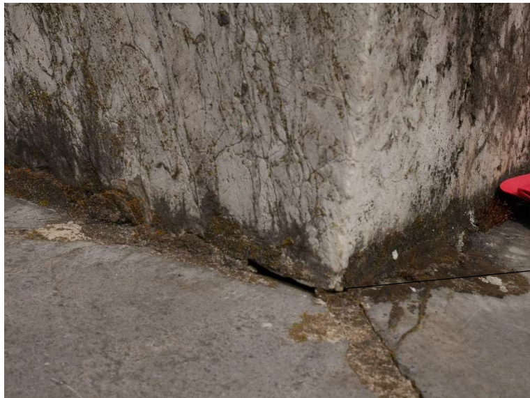
Ouverture des joints
