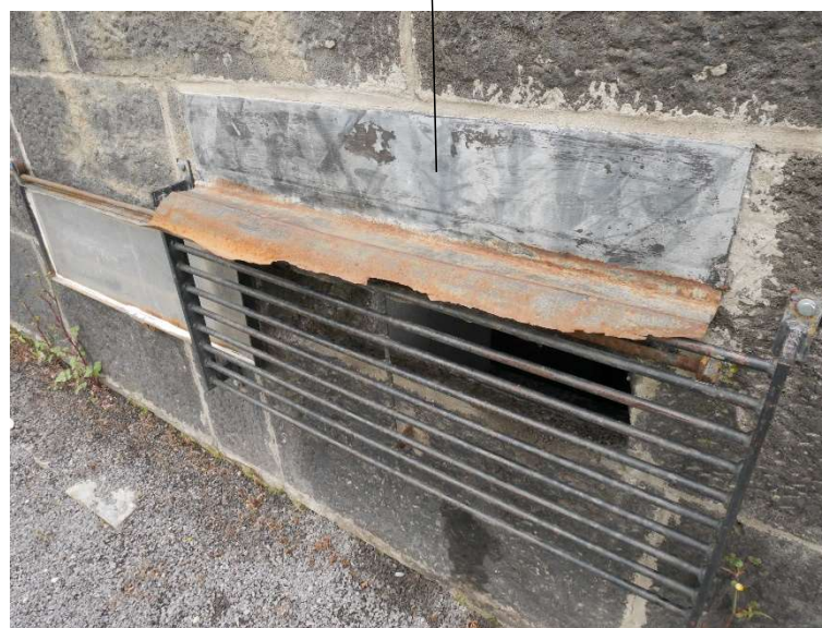
Oxydation du système de fermeture et de l'étanchéité du soubirail
