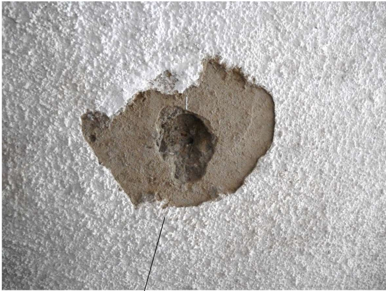
Enduit et peinture blanche sur mortier
