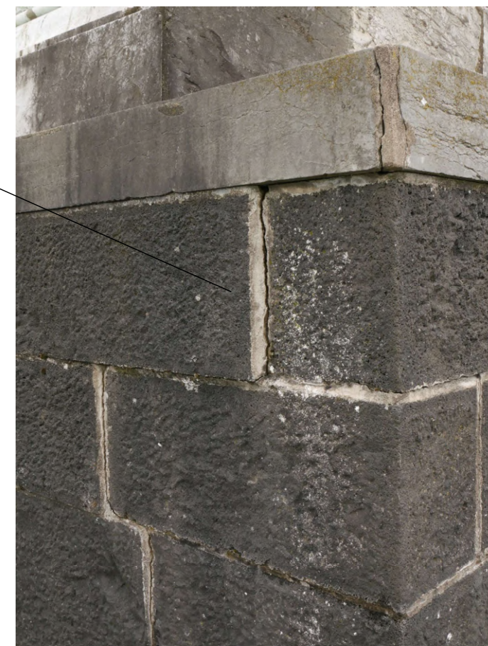
Maçonnerie gonflée ; descellement des blocs et ouverture des joints
