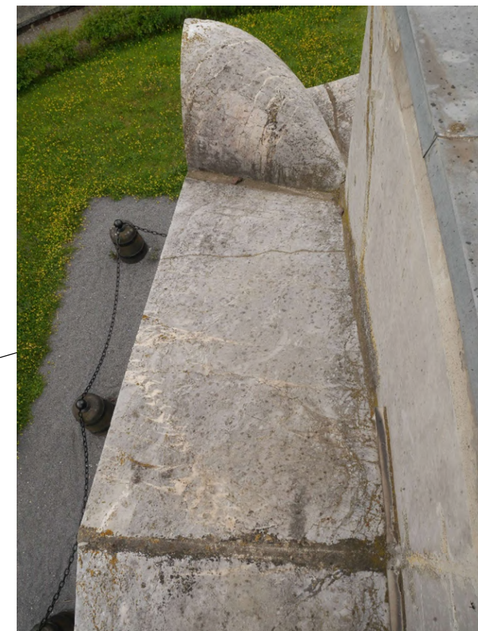
Bloc de marbre couvrant le fronton altéré et fissuré
