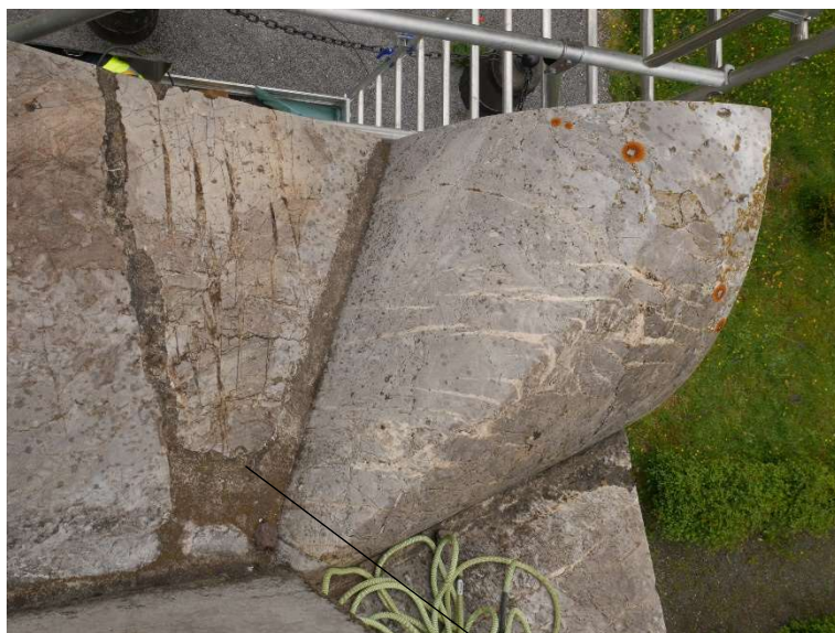
Blocs de marbres altérés ; rebouchage de fissures au mortier de ciment
