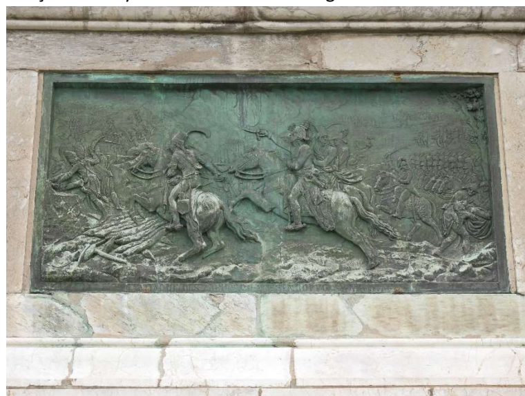
Plaques de bronze altérées ; coulures d'oxyde de cuivre
