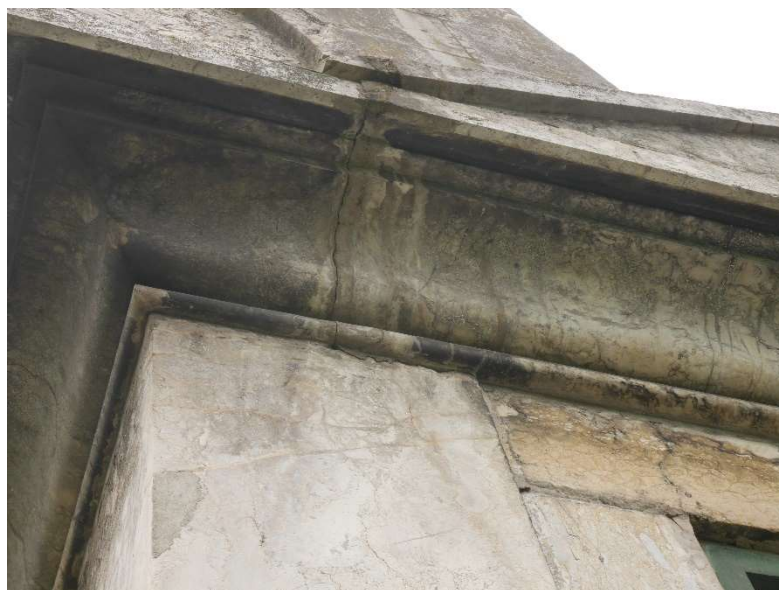
Mouvement et décalage des blocs de marbres entrainant une ouverture des joints
