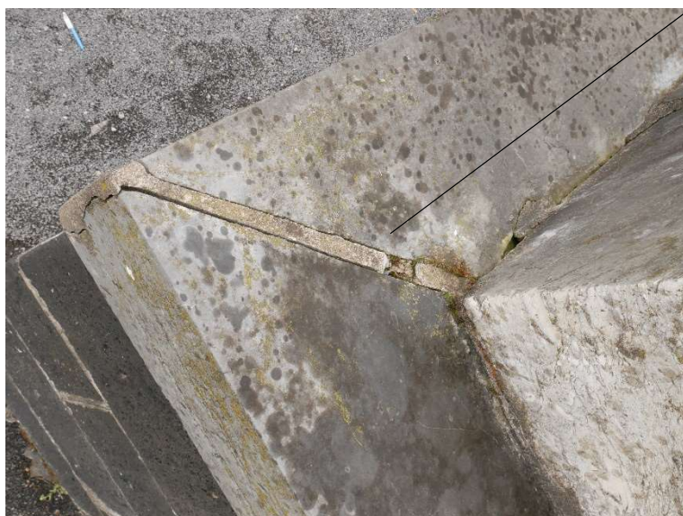
Joints épais au mortier de ciment & ouverture de joint
