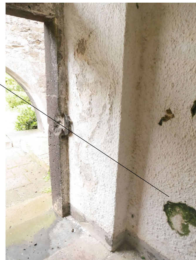
Efflorescence près de l'entrée
