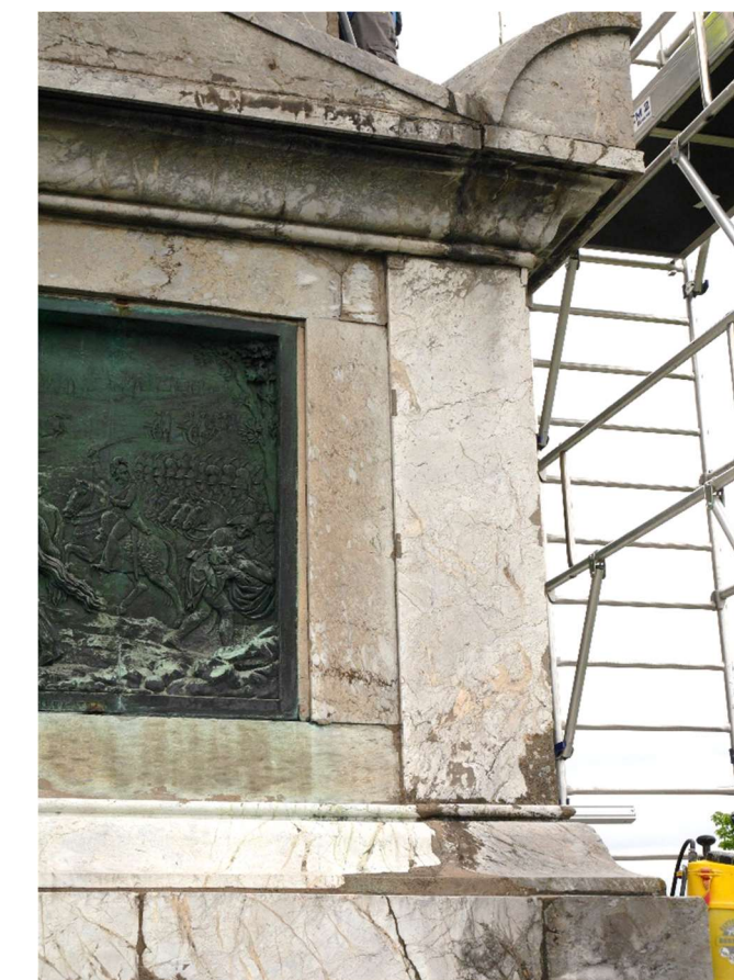
Blocs de marbre très altérés et fissurés ; mouvements de maçonnerie ayant entraîné des décalages
