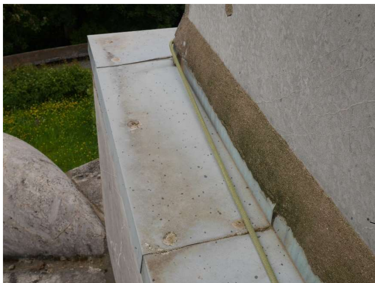
Couvertine en zinc et solin en mortier altérés
