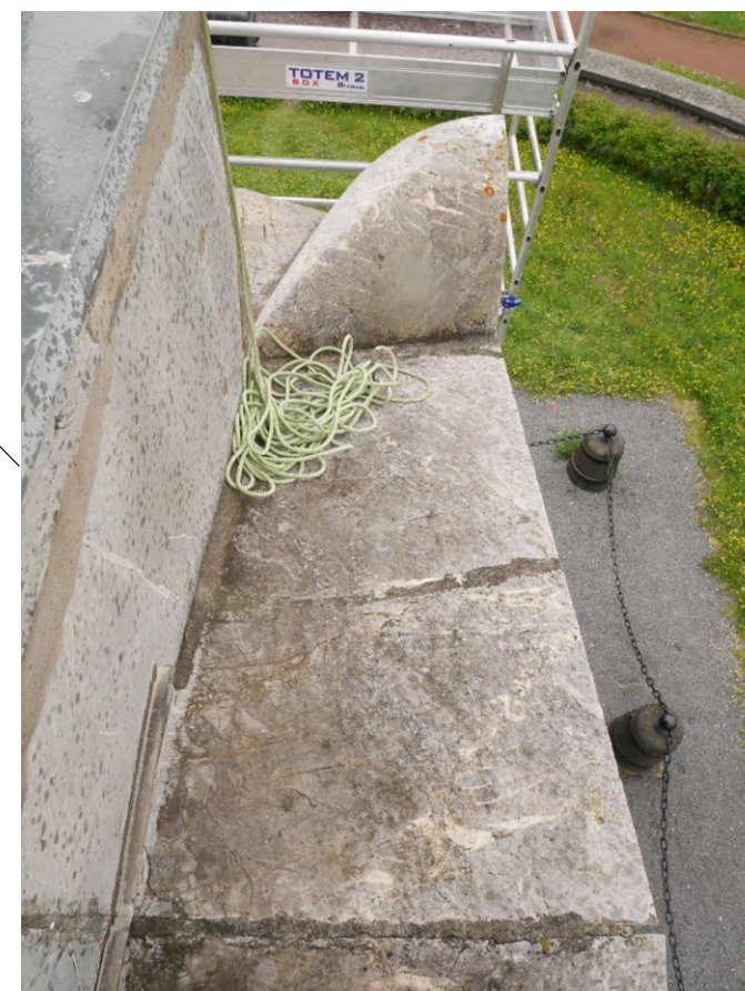
Bloc de marbre couvrant le fronton brisé et rebouché au mortier de ciment
