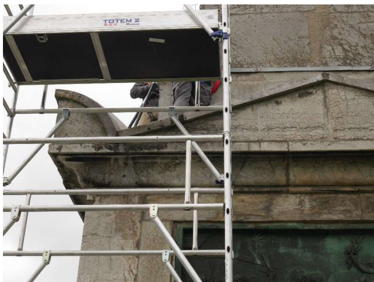
Blocs de marbre très altérés et fissurés ; mouvements de maçonnerie ayant entraîné des décalages
