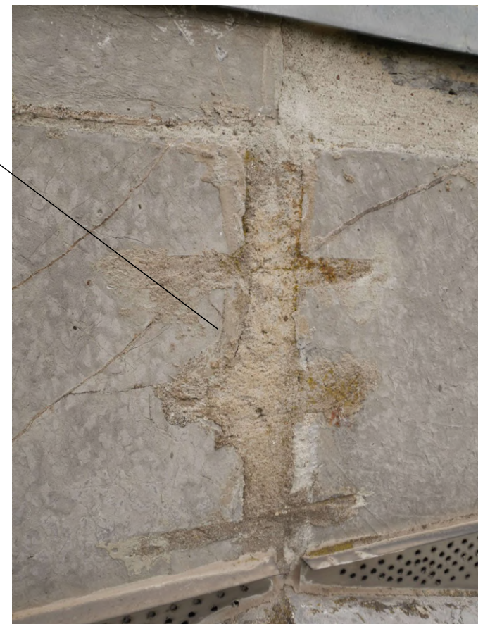
Agrafes, rebouchage des joints au mortier de ciment
