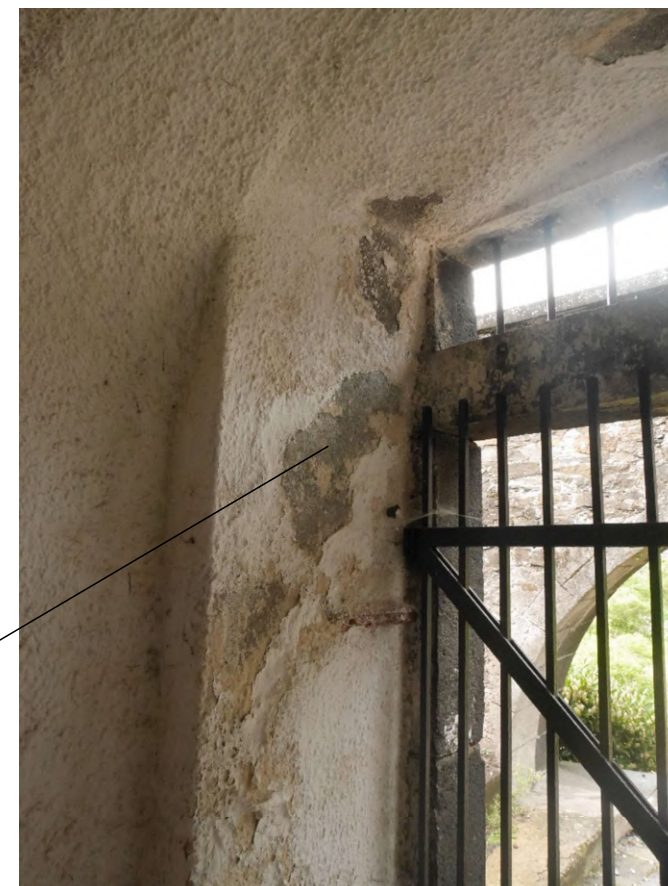
Enduit altéré
