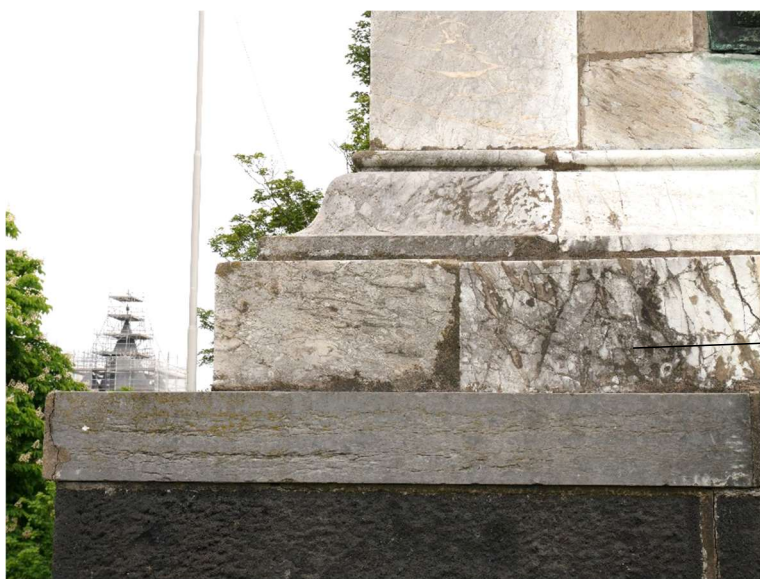
Blocs de marbres altérés et fissurés
