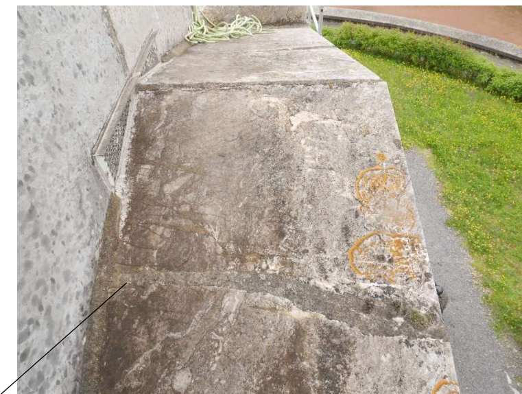
Bloc fracturé, rebouchage au mortier de ciment
