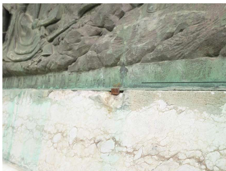
Oxydation des attaches de la plaque en bronze ; coulures d'oxyde de cuivre
