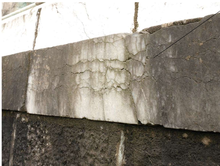
Bloc très altéré (fissures et épaufrures)
