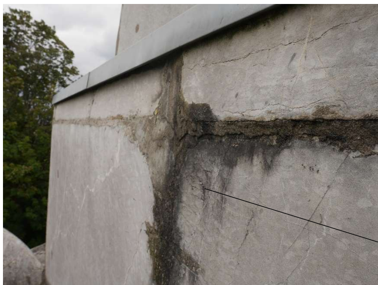
Joint épais au mortier de ciment ; résurgences ayant entraîné un noircissement des parements
