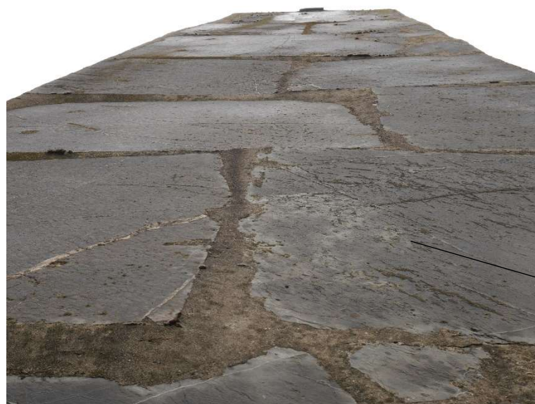
Appareillage du parement de l'obélisque déformé (tendance à s'évaser dans les angles)
