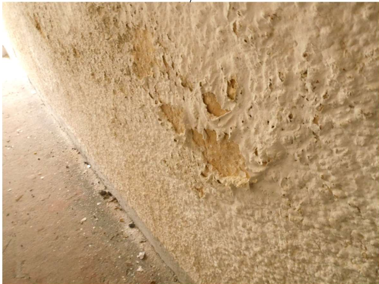
Enduit pulvérulent dans la moitié inférieure du mur
