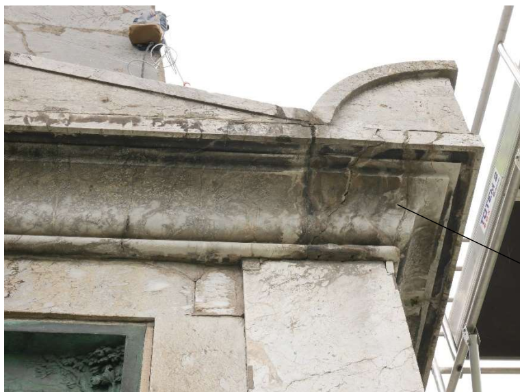
Blocs de marbre fissurés ; décalages entre les blocs
