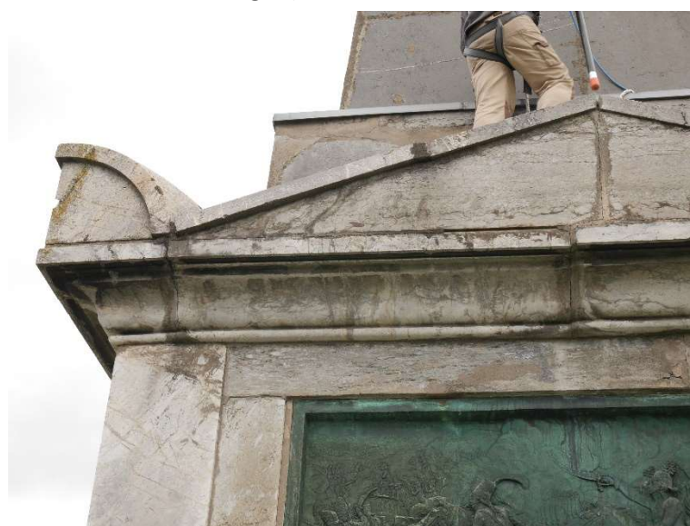
Blocs de marbre très altérés et fissurés ; mouvements de maçonnerie ayant entraîné des décalages
