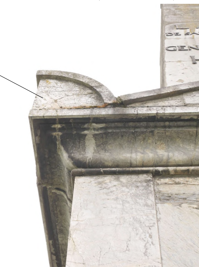
Blocs de marbre fissurés
