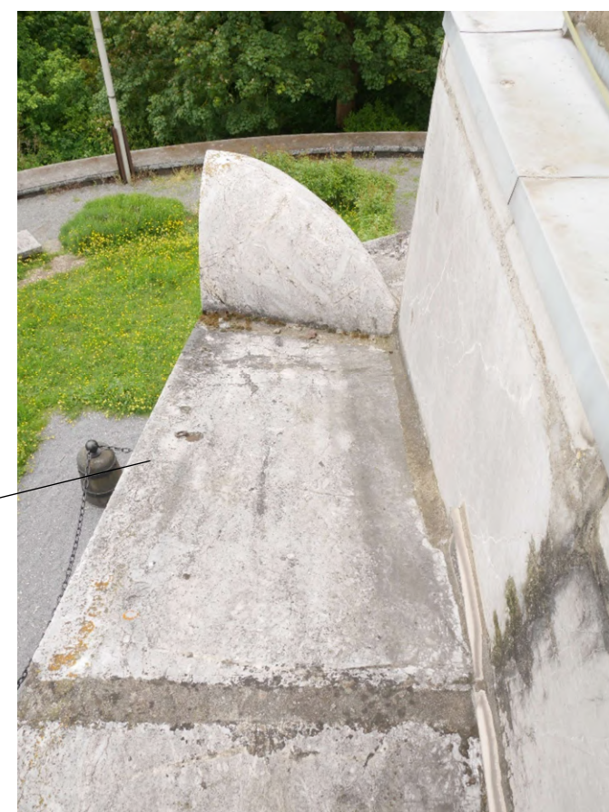
Joint très épais au mortier de ciment ; anneau métallique encastré dans le bloc de marbre
