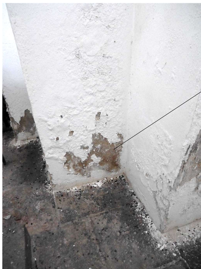
Humidité et enduit pulvérulent en pieds de mur
