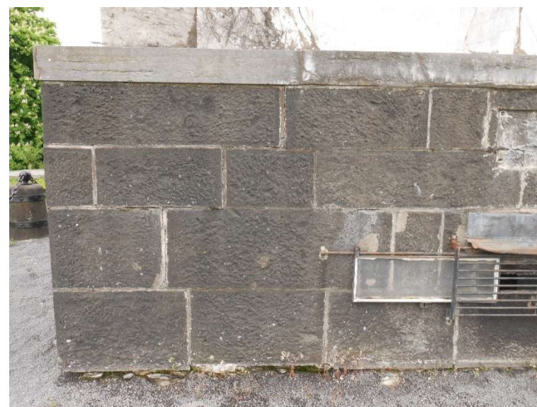
Dallage périphérique disparu ; ouverture de joints
