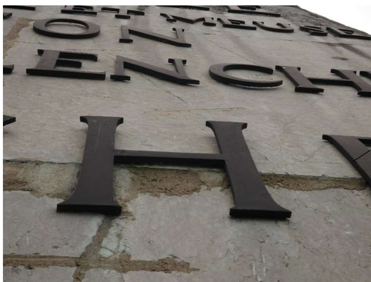
Lettres de l'épithaphe en bronze solidement scellées ; fissures
