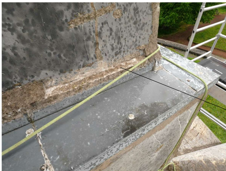
Couvertine en zinc et solin en mortier manquant
