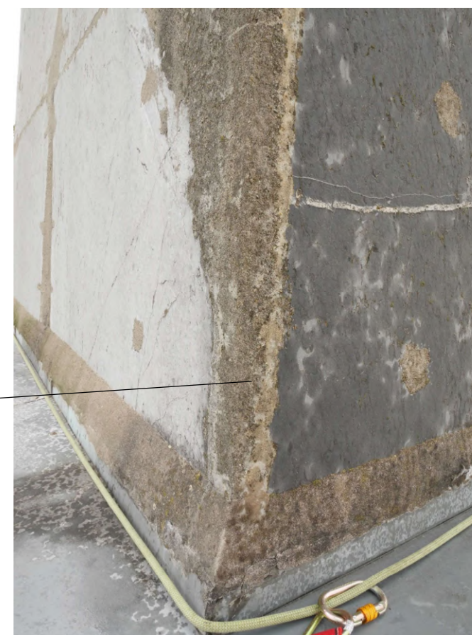
Arêtes de l'obélisque rejointoyés au mortier de ciment
