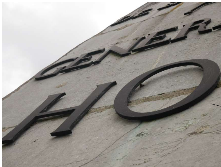
Lettres de l'épithaphe en bronze solidement scellées ; fissures
