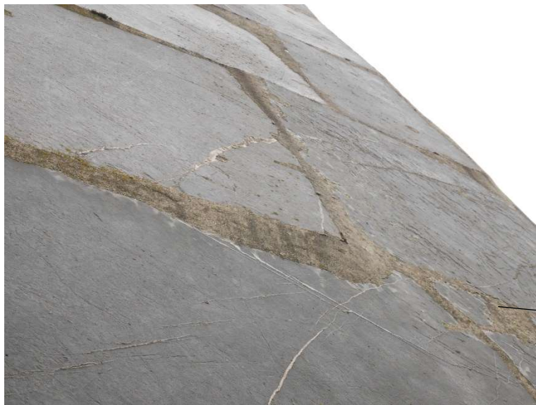
Bloc de altéré et joints en mortier de ciment
