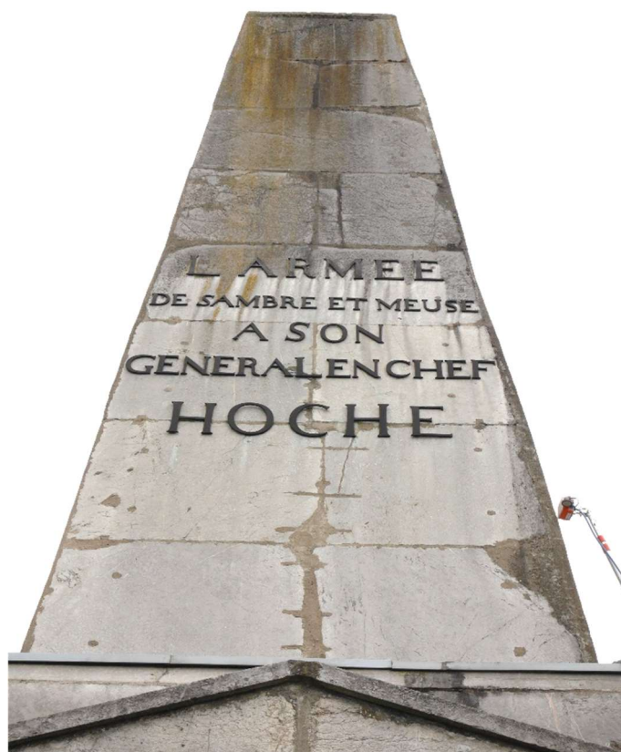
Nombreux blocs de parement altérés ; lichens en partie haute
