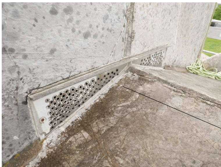
Ouverture sur des puits d'aération à l'intérieur de la base
