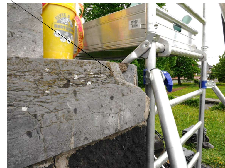
Bloc altéré et épaufrure à l'angle
