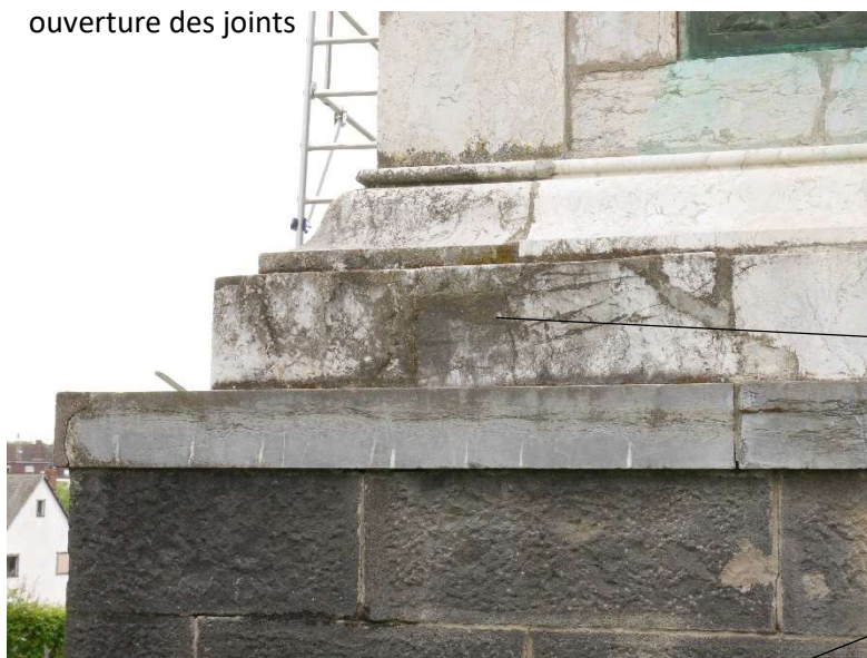
Blocs de marbre très altérés
