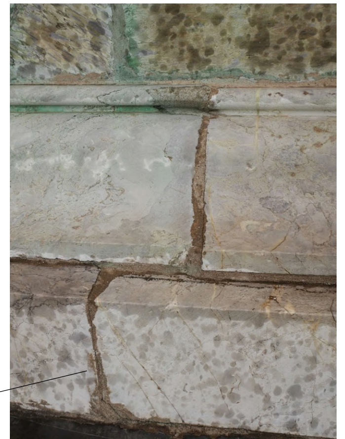
Bloc de marbre altéré et joint en mortier de ciment
