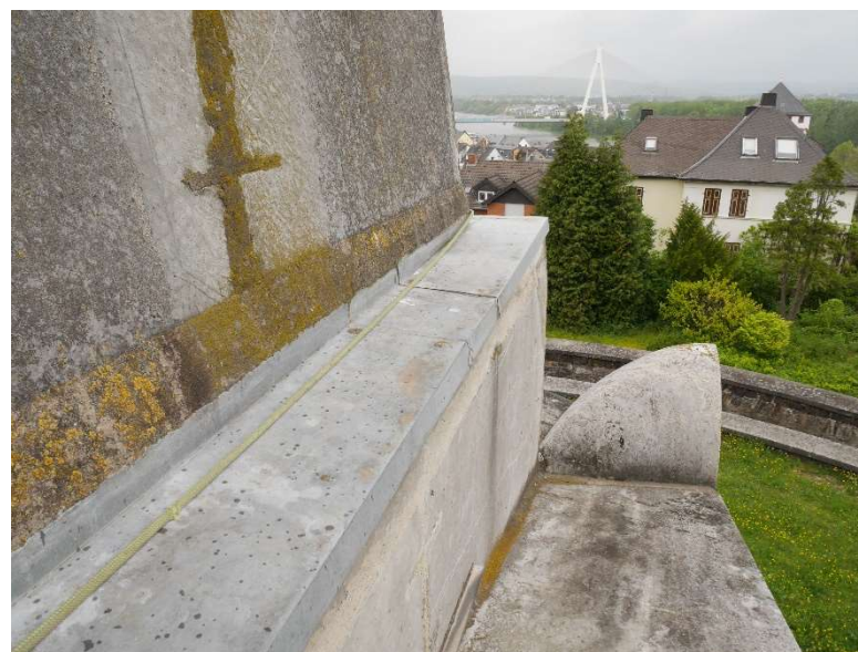
Couvertine et solin en mortier de ciment
