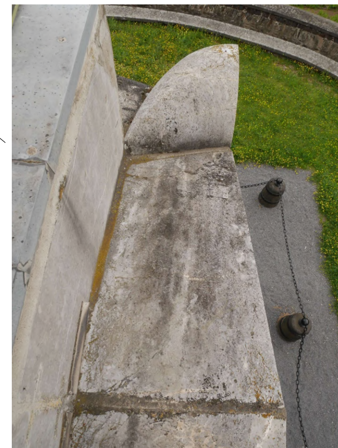
Bloc de marbre couvrant le fronton altéré ; joints très épais au mortier de ciment
