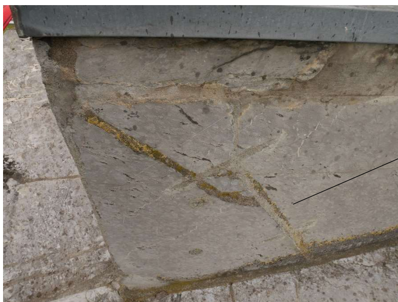
Agrafes et rebouchage de fissures au mortier de ciment
