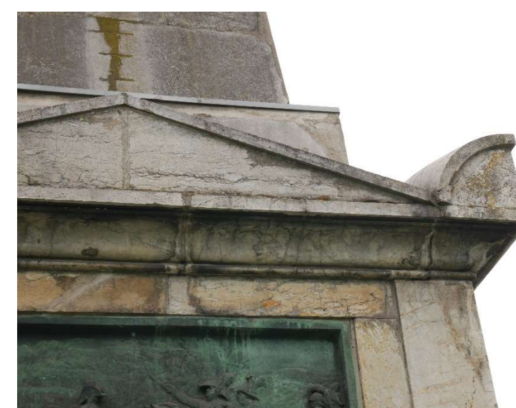
Mouvement et décalage des blocs de marbres entraînant une ouverture des joints
