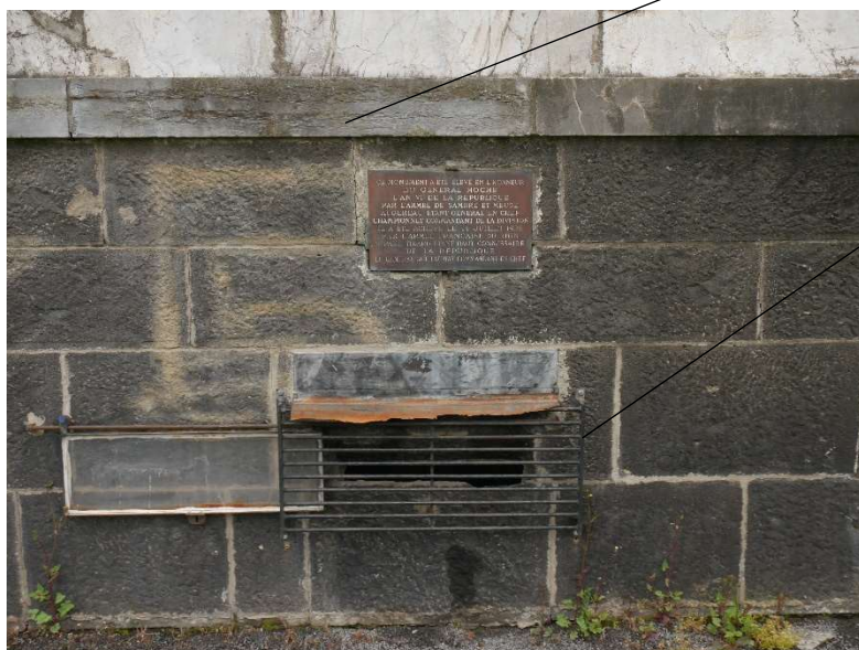
Oxydation du système de fermeture et de l'étanchéité du soupirail ; blocs de pierre altérés
