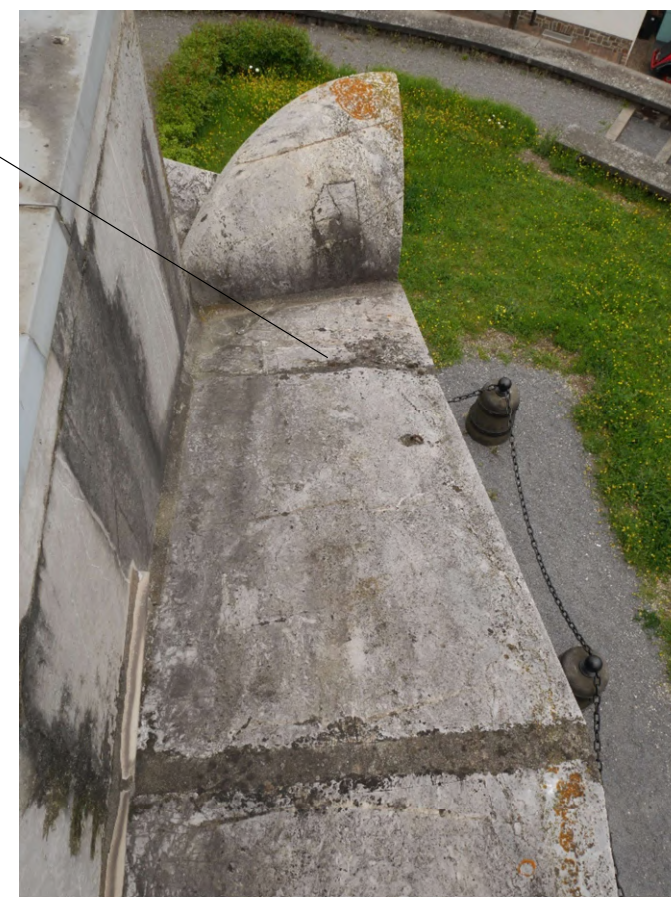
Blocs de marbre du fronton fissurés et brisés ; anneau métallique encastré
