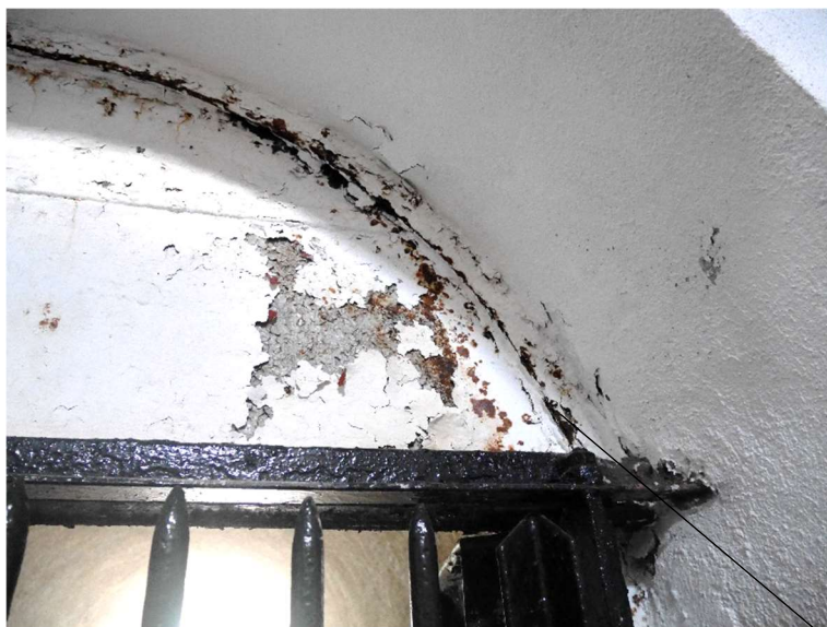
Plaques métalliques de l'imposte oxydées
