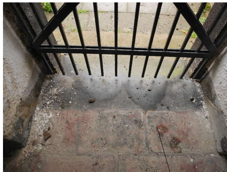
Grosse pierre de seuil schisteuse ; couloir en terre cuite
