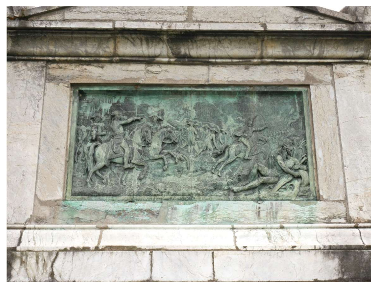
Bas-relief en bronze altéré ; coulures d'oxyde de cuivre
