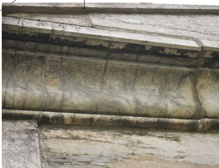
Bloc de marbre très altéré et fissuré, bloc de parement du fronton brisé ; ouverture de joints
