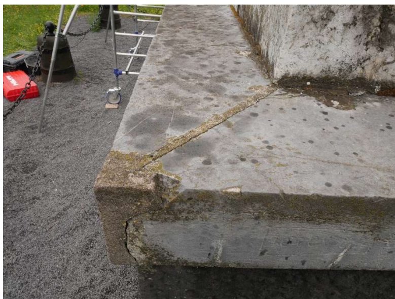
Rebouchage de joint au mortier de ciment ; joint ouvert ; épaufrures
