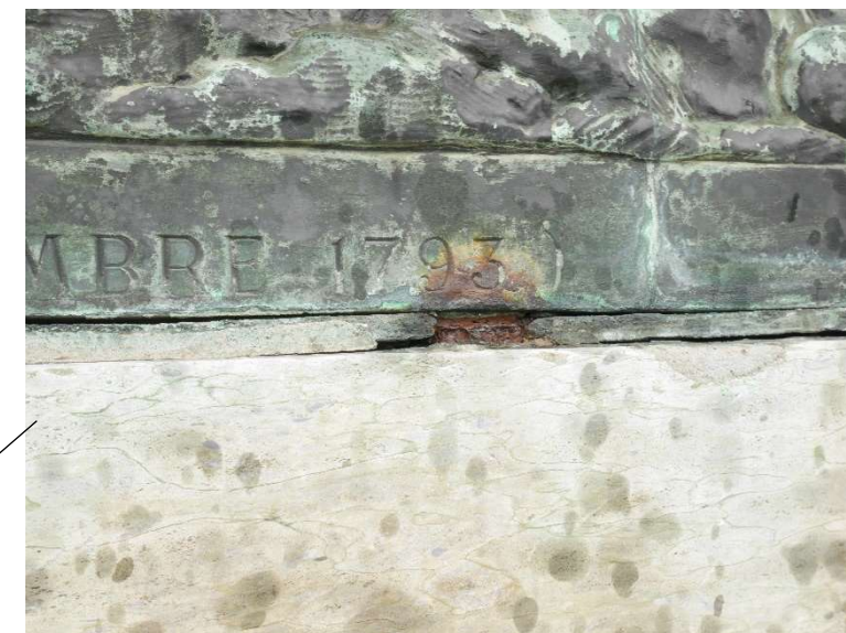
Oxydation de l'attache en fer de la plaque en bronze
