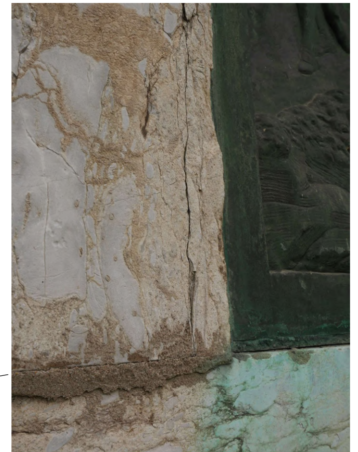
Piédroit en marbre fissuré ; coulures d'oxyde de cuivre
