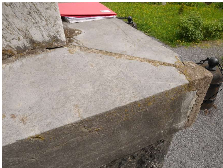
Epaufures comblées par du mortier de ciment ; ouverture des joints
