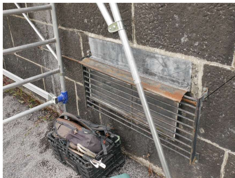
Oxydation du système de fermeture et de l'étanchéité du soudoir
