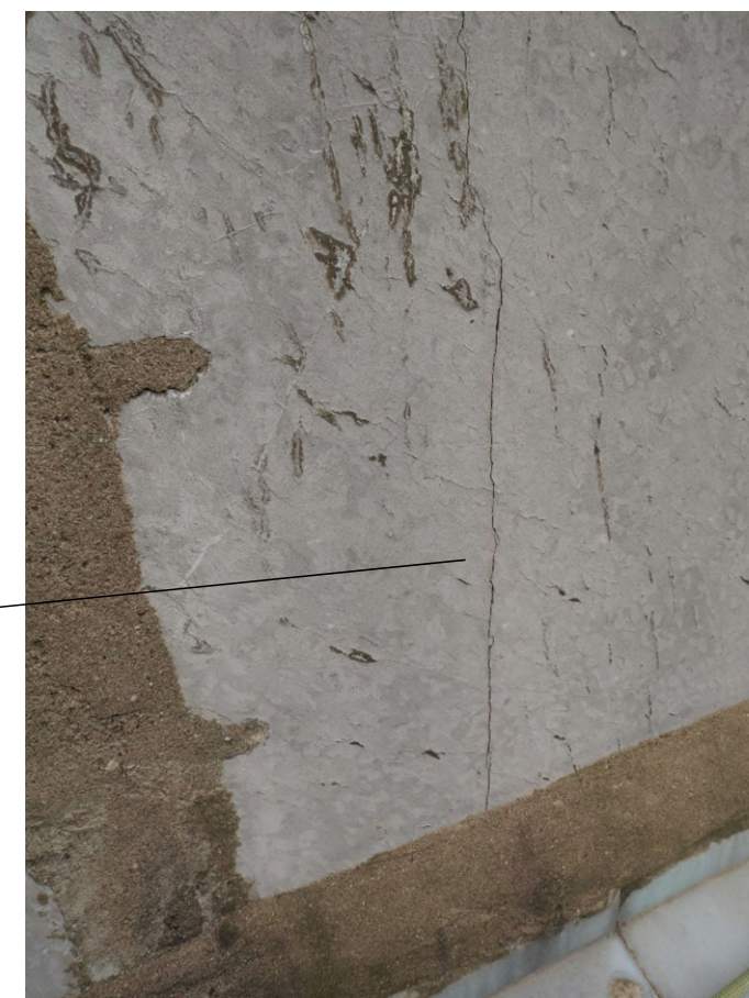
Fissure dans les blocs de parement de l'obélisque
