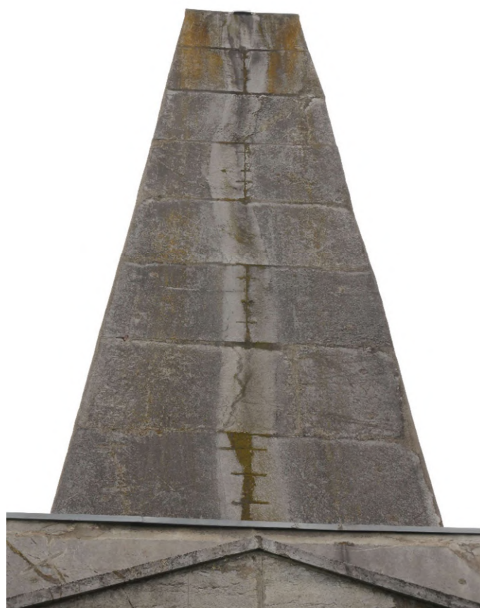
Agrafes et rebouchage de fissure au mortier de ciment
