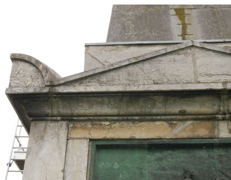
Blocs de marbre très altérés
