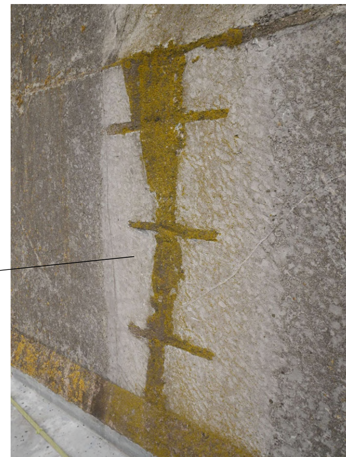
Agrafes et rebouchage de joints au mortier de ciment
