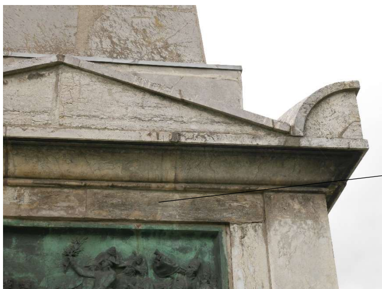
Blocs de marbre très altérés ; mouvements de maçonnerie ayant entraîné des décalages
