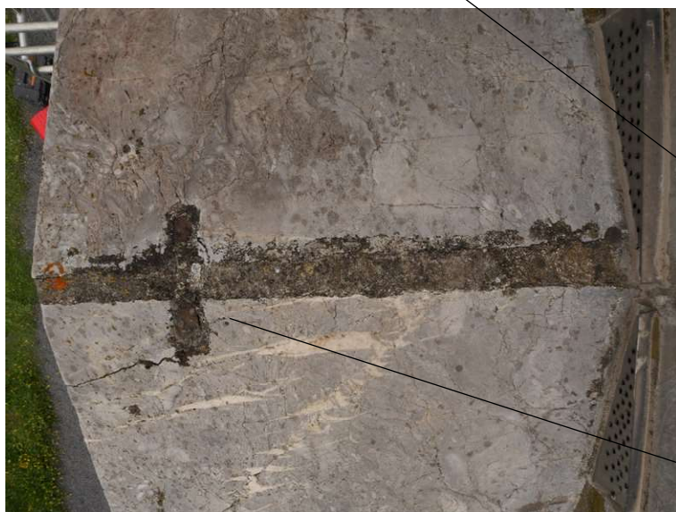
Oxydation d'une agrafe ayant fracturé le bloc de marbre
