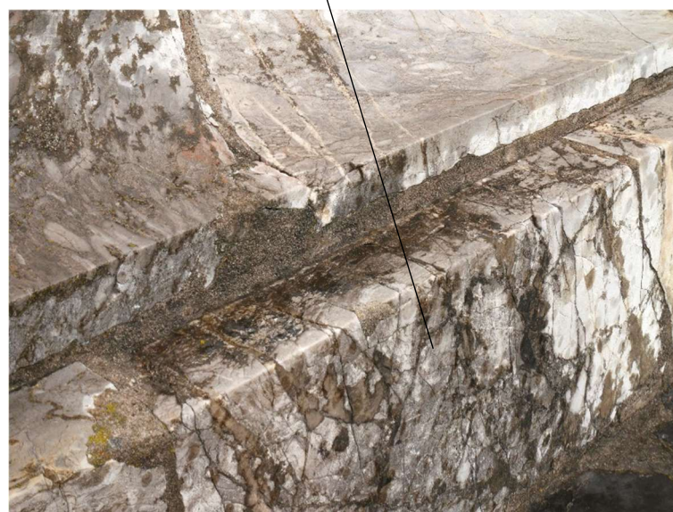
Bloc de marbre altéré
