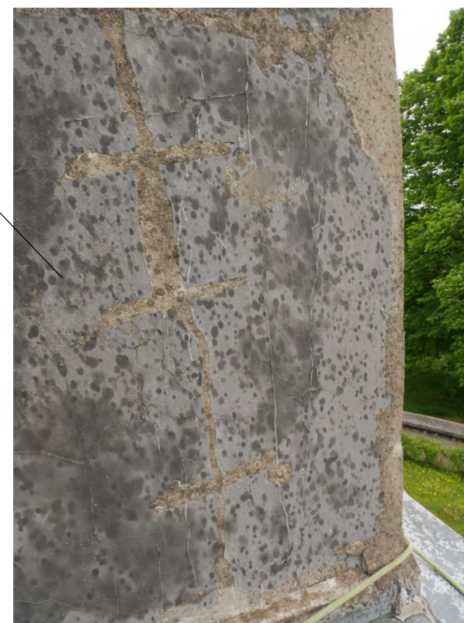
Agrafes et mortier de ciment en rebouchage d'une fissure
