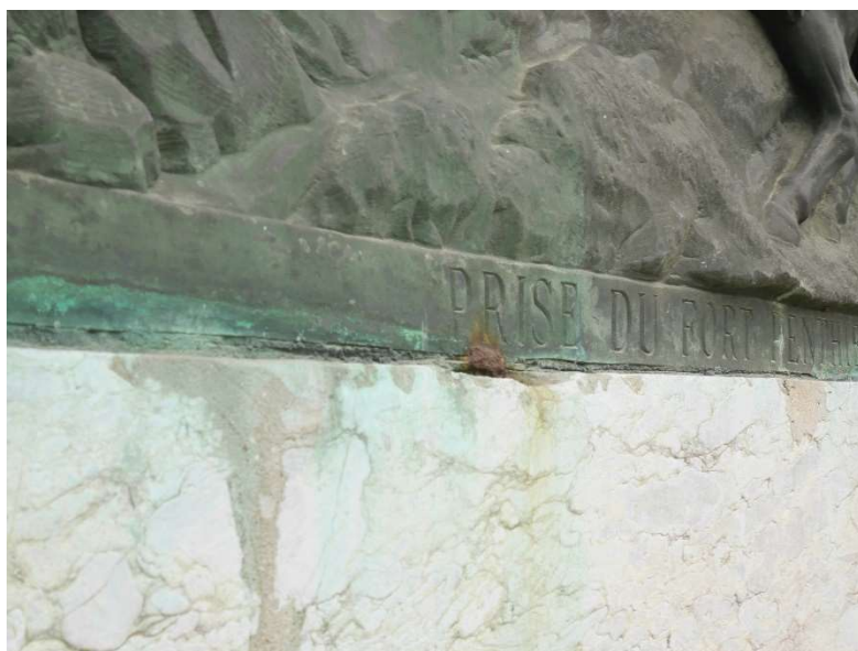
Attaches des plaques de bronze oxydées; coulures d'ox. de cuivre
