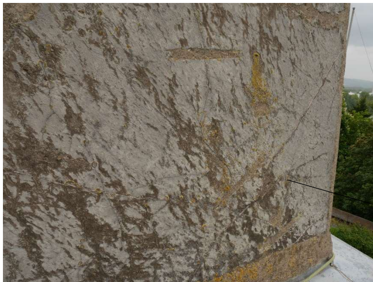
Blocs de parement de l'obélisque fissurés ; agrafes et rebouchage des fissures avec du mortier de ciment
