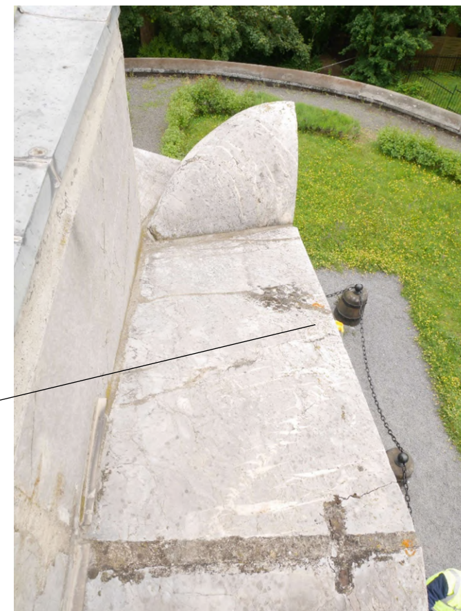
Blocs de marbre couvrant le fronton fissurés et fracturés ; agrafe métallique
