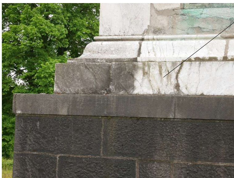
Blocs de marbre très fissurés
