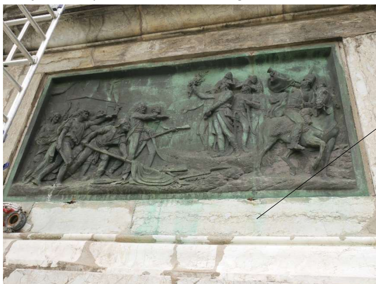
Bas-relief en bronze ; coulure d'oxyde de cuivre ; blocs de marbres altérés
