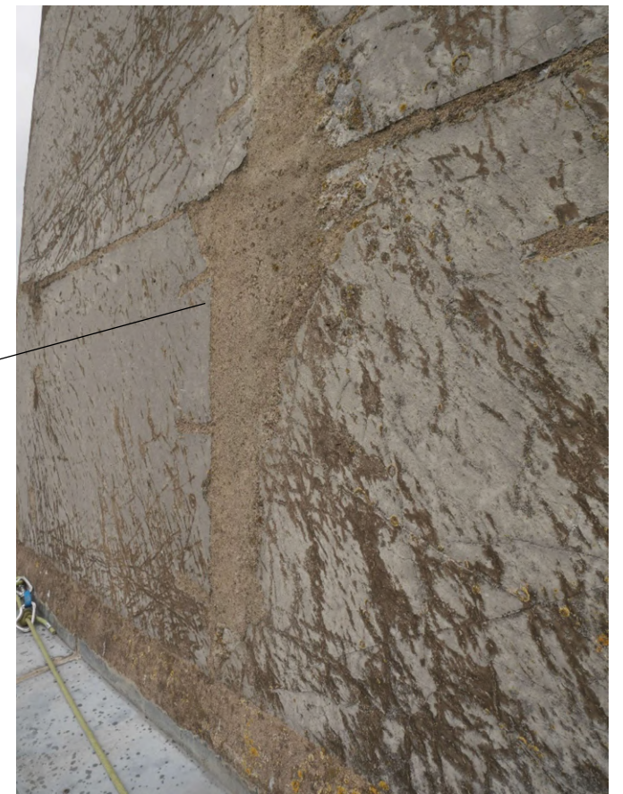
Joints très épais au mortier de ciment
