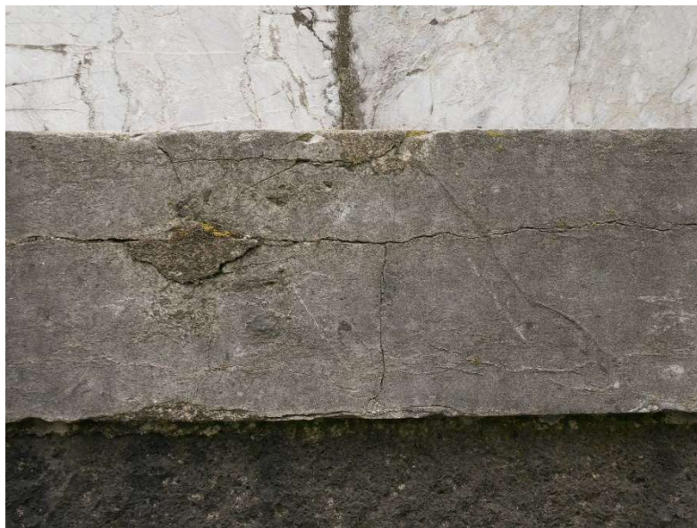
Bloc très altéré et fissuré
