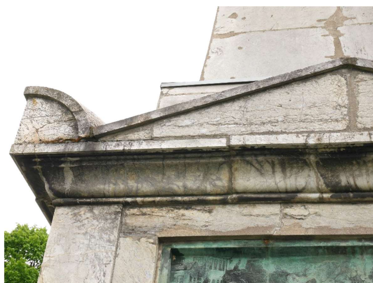
Blocs de marbre très altérés et fissurés
