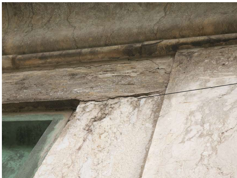
Blocs de marbre altérés et fissurés ; ouverture de joints
